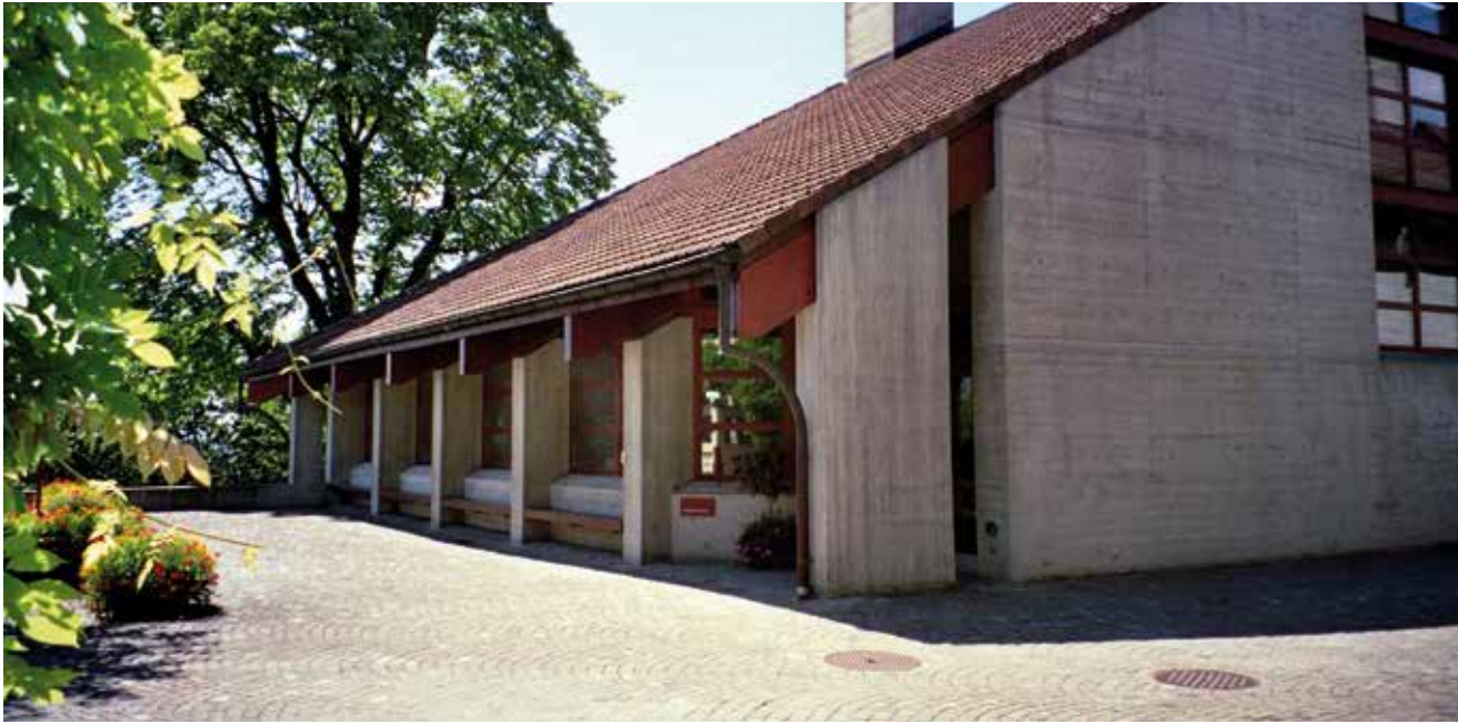
Gewerbegebäude (Schreinerei, Malerei)
